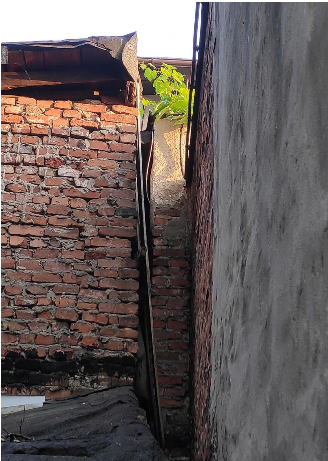
Budynek mieszkalny przeznaczony do rozbiórki; po prawej widoczne ściany sąsiedniego budynku, nieprzeznaczonego do rozbiórki; widoczna szczelina pomiędzy ścianami budynków.
