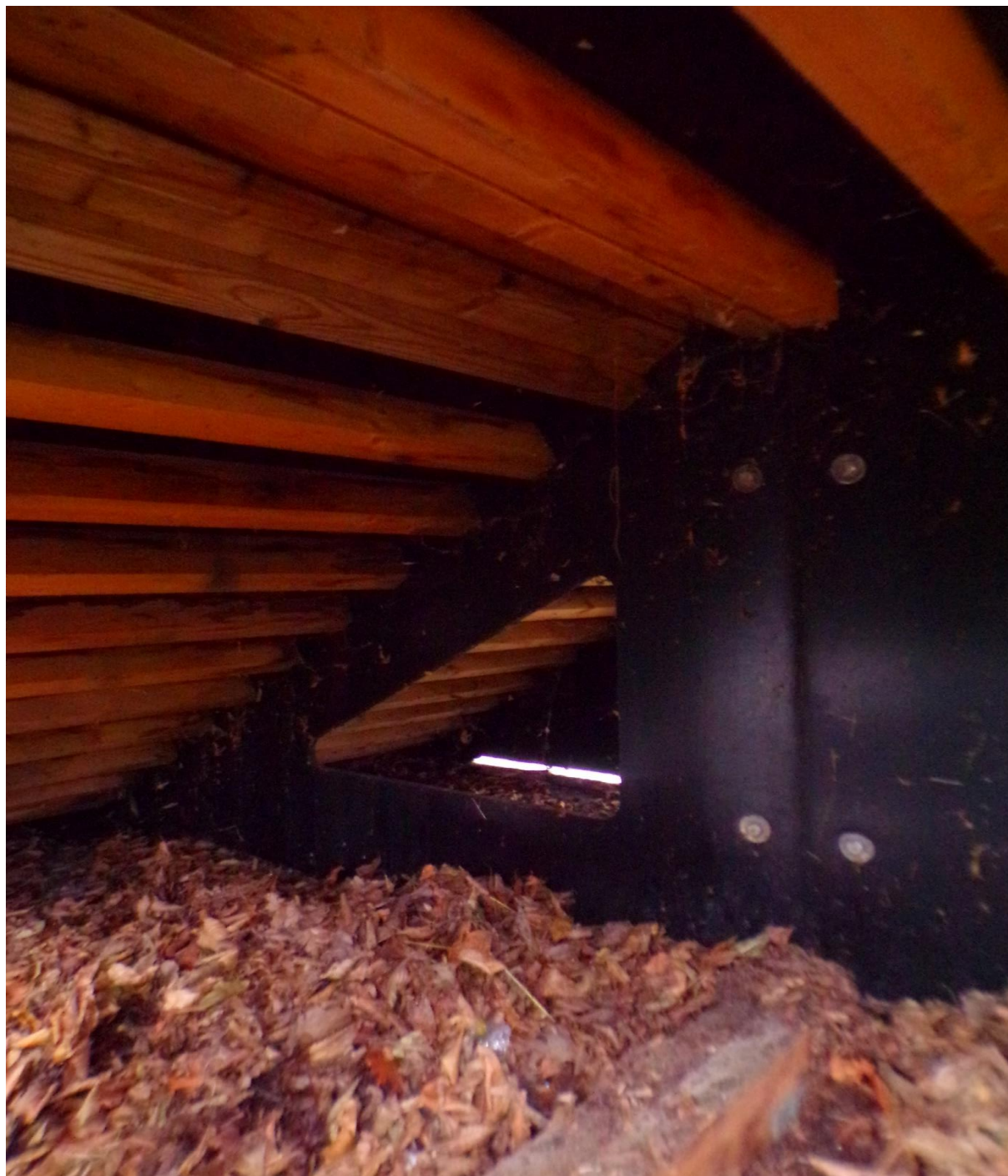
Widok wewnętrznej konstrukcji urządzeń skateparku
