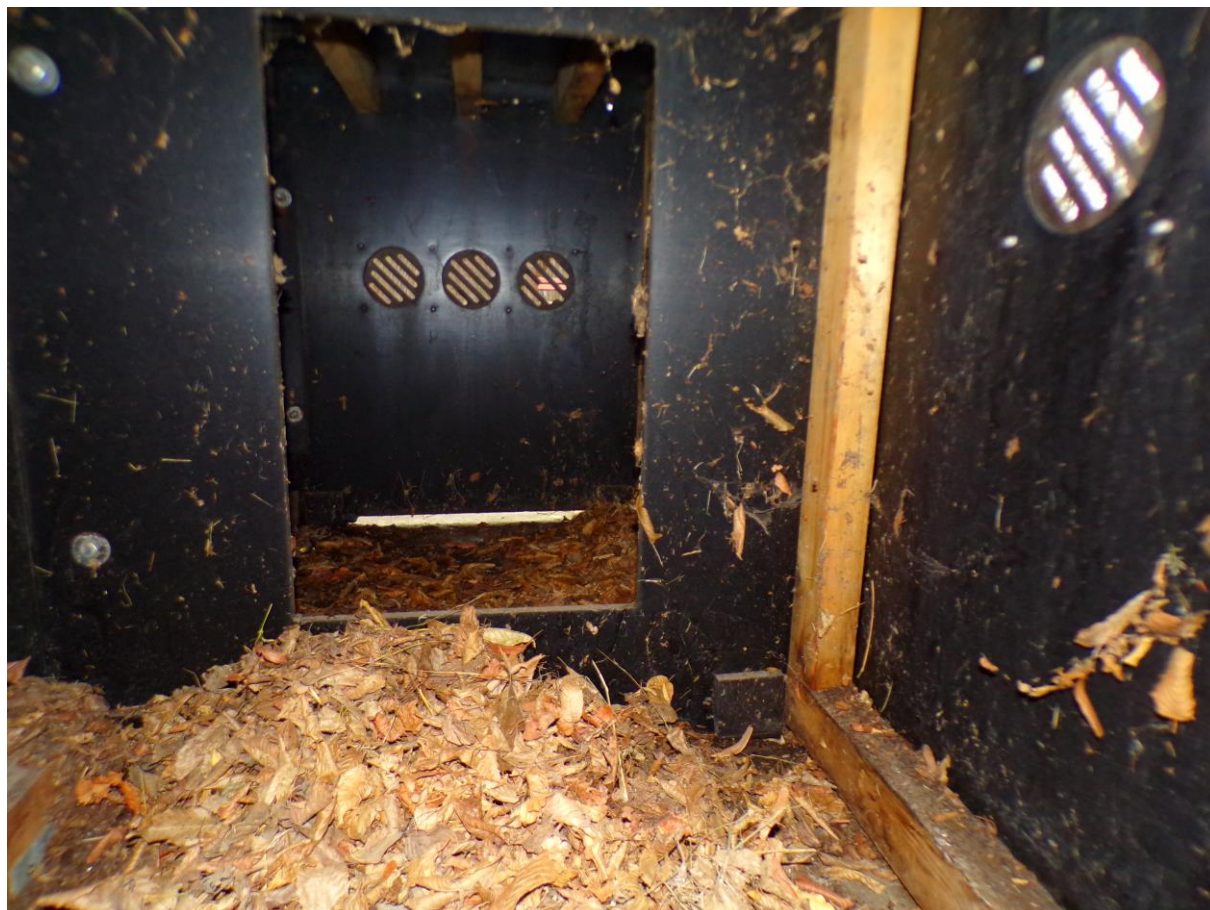
Widok wewnętrznej konstrukcji urządzeń skateparku
