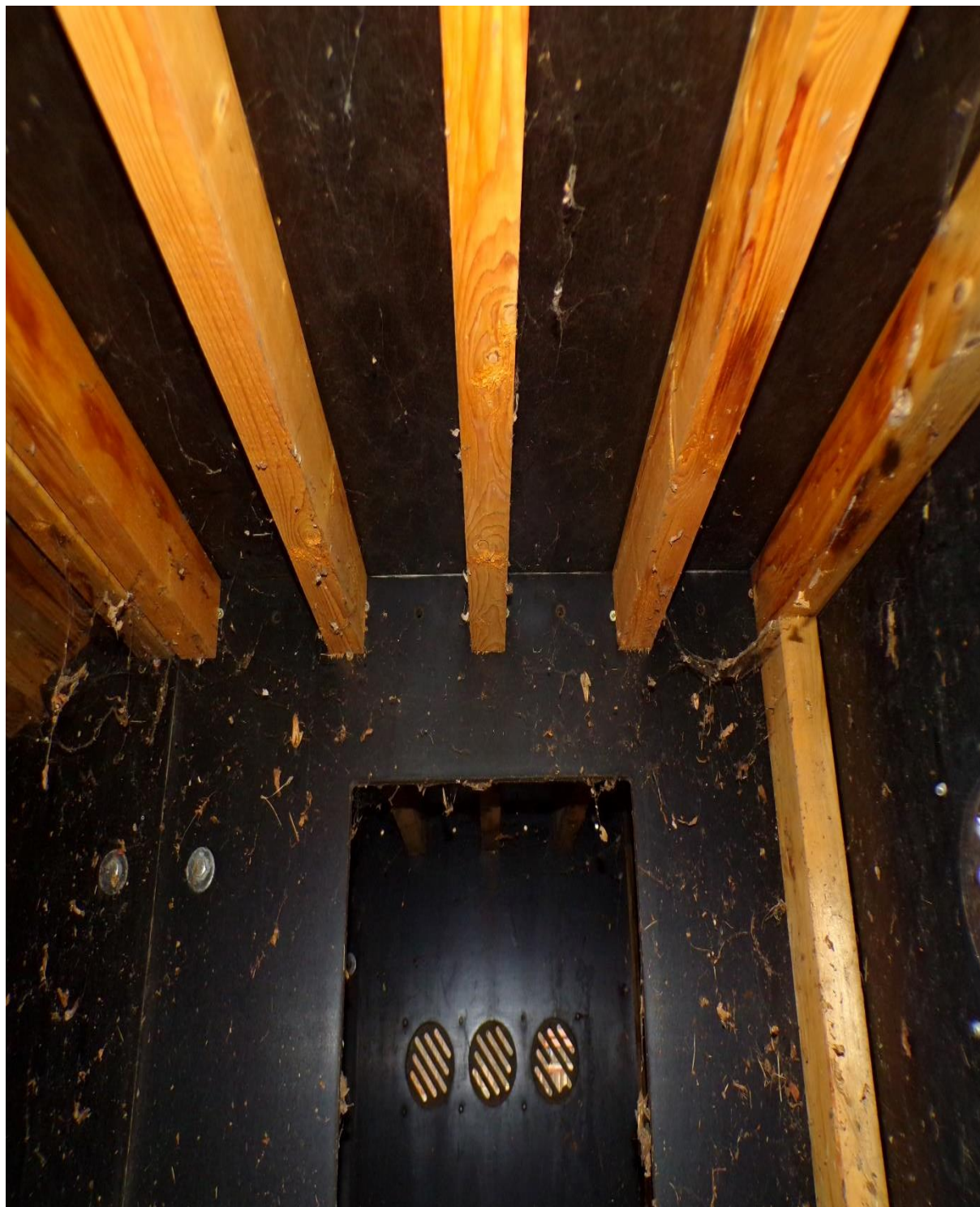
Widok wewnętrznej konstrukcji urządzeń skateparku.
