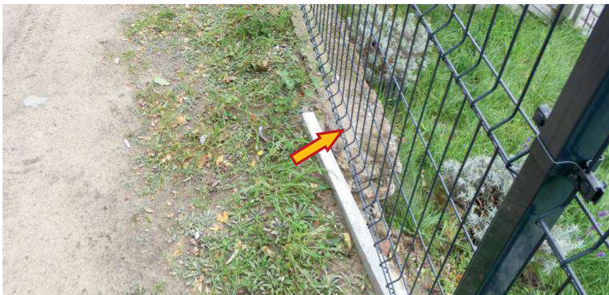
Fot. 3 Pozostałości usuniętej murowanej ściany oporowej
