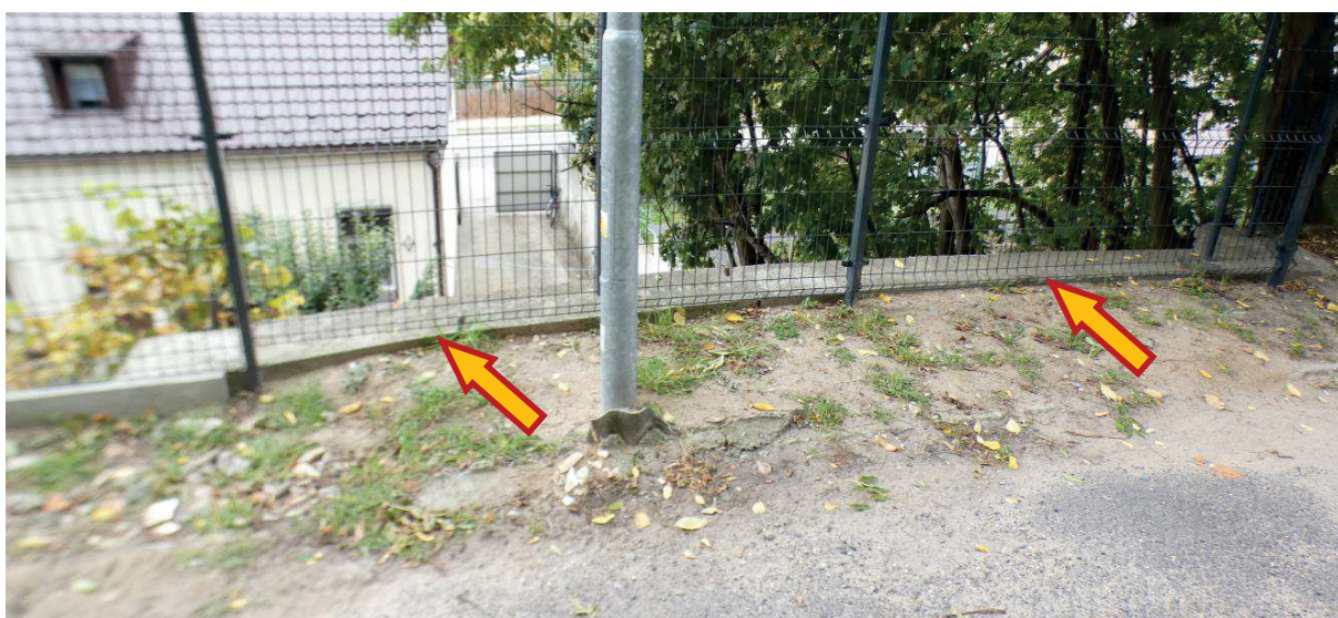
Fot. 4 Odtworzona nowa ściana oporowa w miejscu starego muru oporowego.
