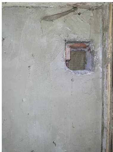
Fot. 17 Okno od strony sąsiada widoczna warstwa dylatacyjna z wełny skalnej
