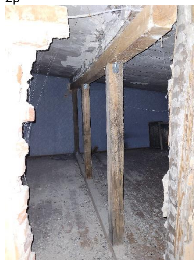
Fot. 30 Stemple podtrzymujące więźbę
