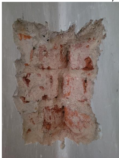
Fot. 14 Odkrywka nr 2, widoczne przewiązane cegły
