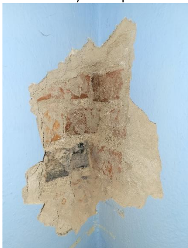
Fot. 13 Odkrywka nr 1, widoczne przewiązane cegły
