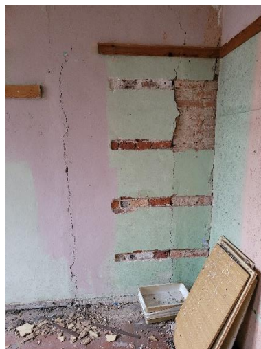
Fot. 18 Uszkodzenia ściany w pomieszczeniu na 2p
