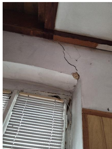
Fot. 27 Uszkodzenia ściany na 2p
