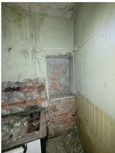
Fot. 16 Zamurowane okno od strony sąsiada
