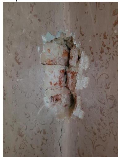
Fot. 15 Odkrywka nr 3, widoczne przewiązane cegły
